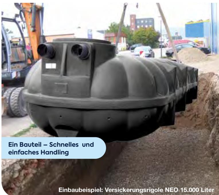
Einbaubeispiel: Versickerungsrigole NEO 15.000 Liter
