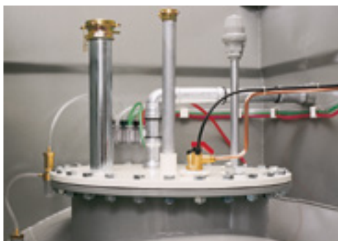
Komplett-Tank unterirdisch mit montierter Tankarmatur
